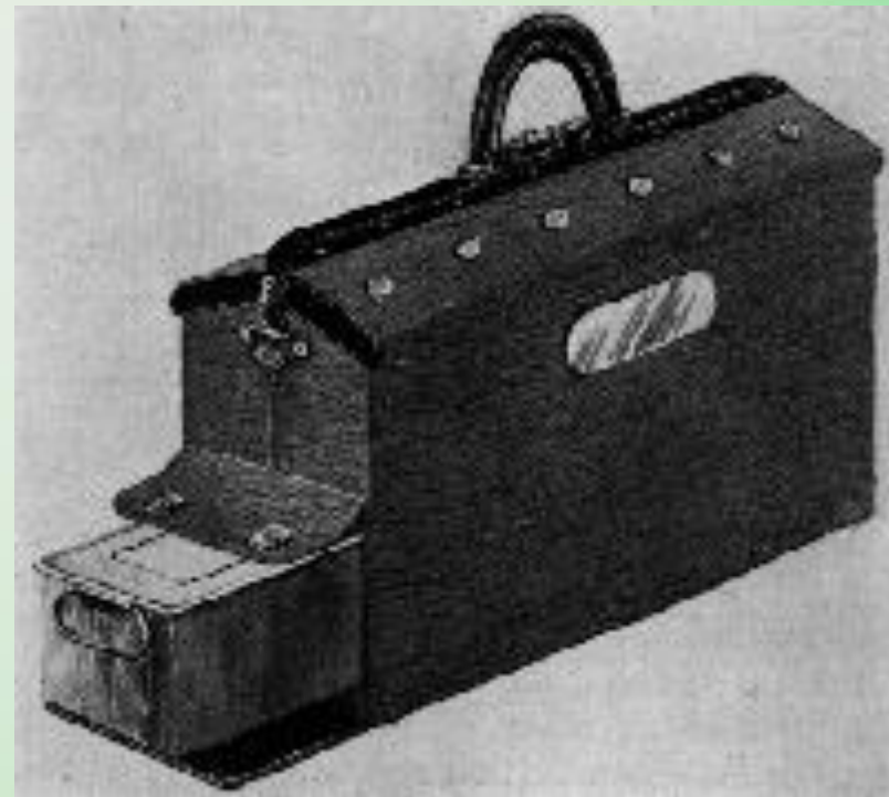
Porodnická brašna s falešným dnem, sloužící jako transportní inkubátor (J.Hess)
