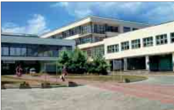
Rekonstruované nádvoří Dětské nemocnice
